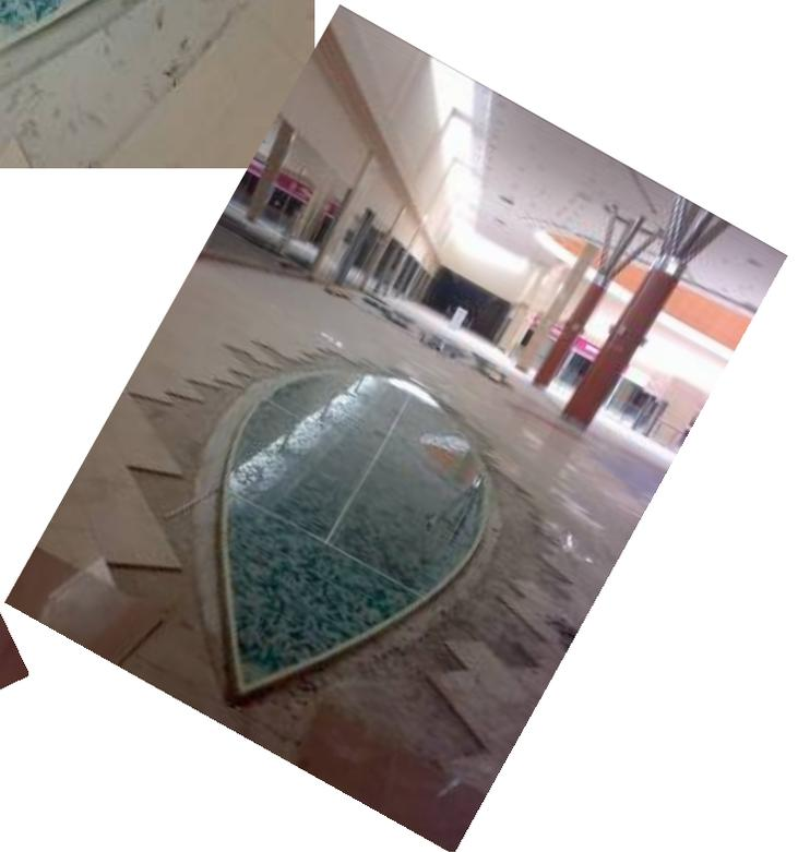
Здесь текста много не будет, поэтому наслаждайтесь фотками! Вид снизу: подвесной потолок на креплении «спайдер», стекло матовое, между потолком и полом видна противопожарная перегородка.
