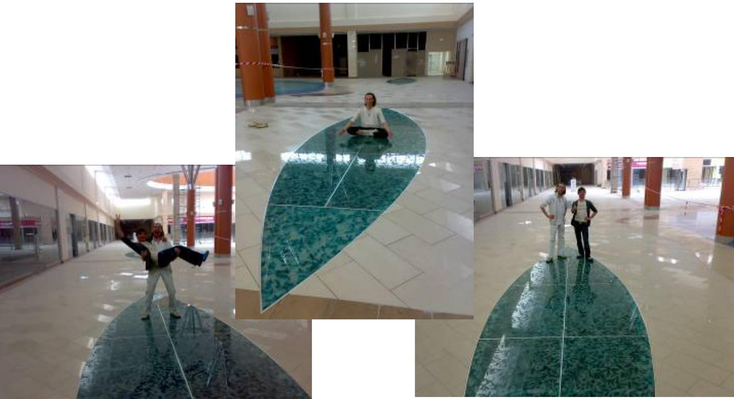
Про пол: триплекс 10\*10\*10, закалённое, на верхнем пескоструйная обработка(листочки), прослойка из полимерной плёнки с сольвентной печатью(листочки), регулировка демпферами, герметизация силиконом, обрамление т-образным профилем с покрытием под полированную нержавейку, каркасная подсистема из металла с порошковой покраской.
